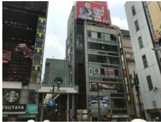
ベルスードビル壁面 「募集中」
