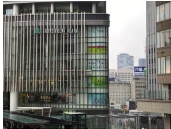
南東角壁面スーパーシート 「自社使用」
