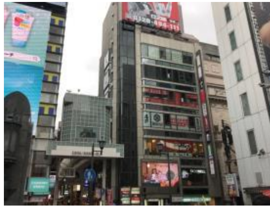
ベルスードビル壁面 「募集中」
