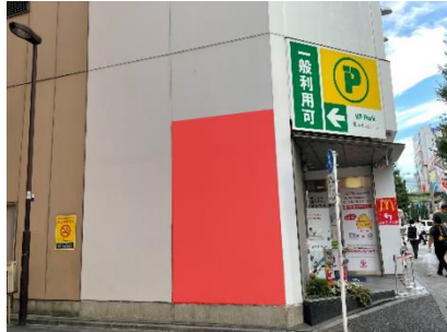
ビックカメラAKIBA 東面
