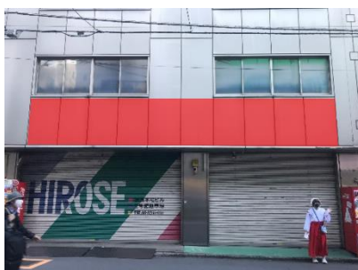
廣瀬本社第2ビル
